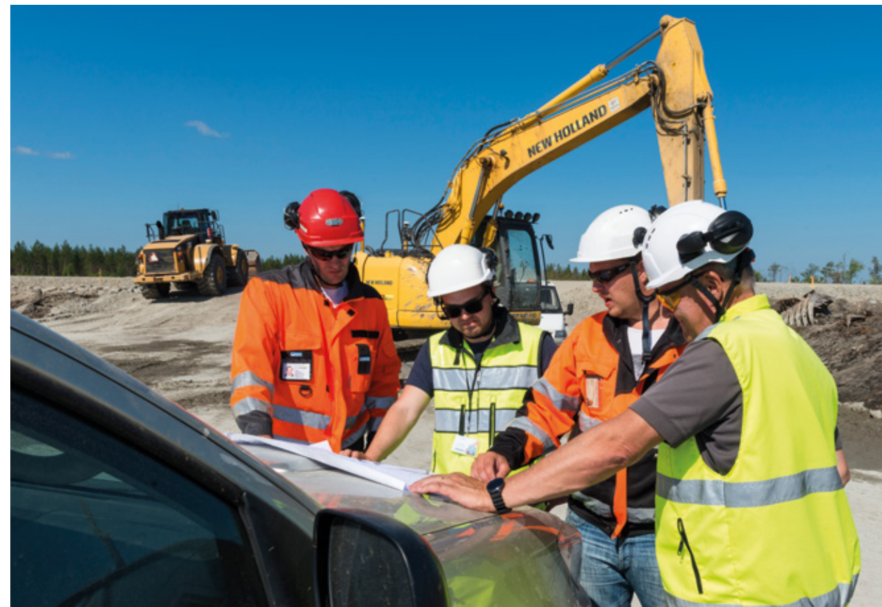
Kaivostoimintaan investoitava raha jää suurelta osin kaivoksen lähialueelle. Kuva Sotkamo Silveriltä.
