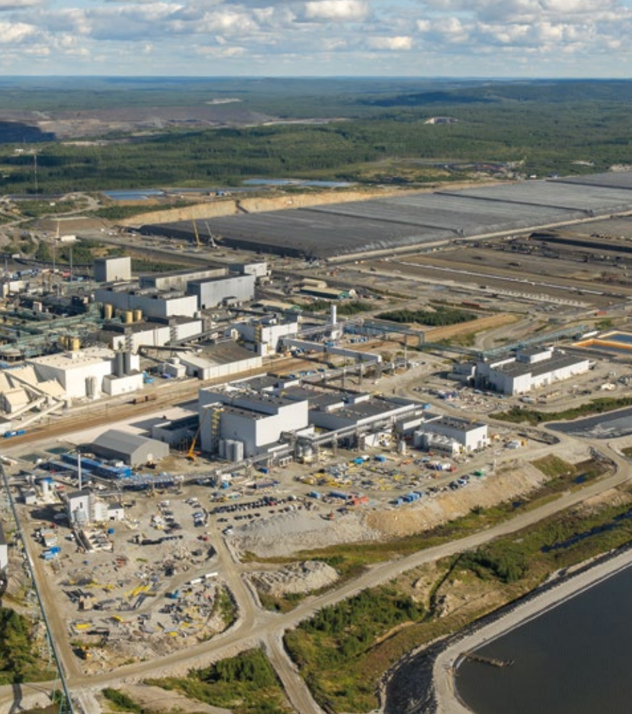
Terrafamen akkukemikaalitehtaan rakennustyömaa etualalla.
