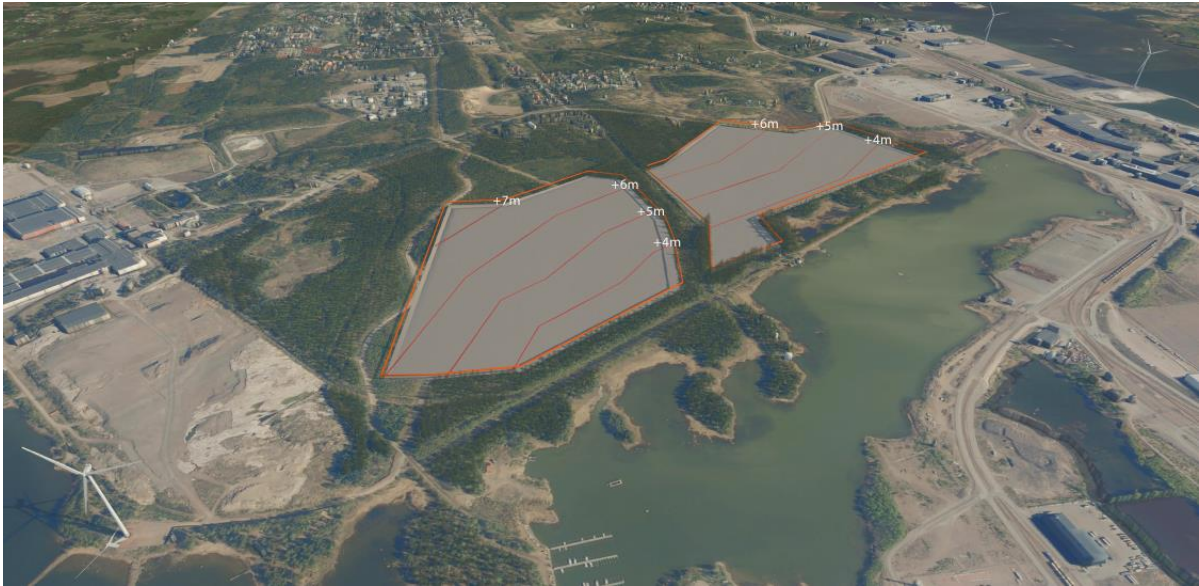
Kuva 15-18. 3D-mallinnetussa viistoilmakuvassa on havainnollistettu harmaina alueina kaupungin asemakaavoitusta varten teettämän suunnitelman mukaiset louhinta-alueet lopputilanteessa. Louhittu maanpinnan taso laskee Hillonlahtea kohti noin 1 %.
